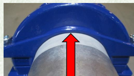
両側のハウジングと鋼管に隙間がない事を確認し施工完了
